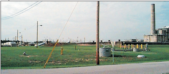
E. 186 - C - Reservoir
