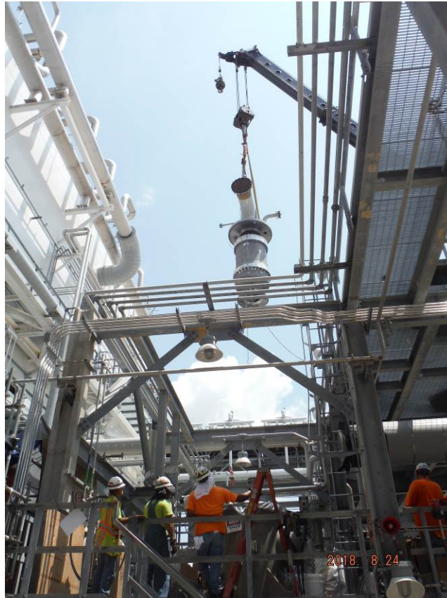
Train 5 – LNG Transfer Pump Installation
