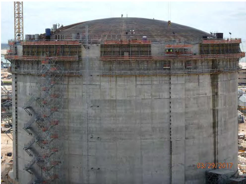
LNG Tank C – Roof Rebar Installation
