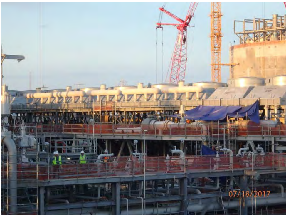
Train 1 – Fin Fan Header Installation
