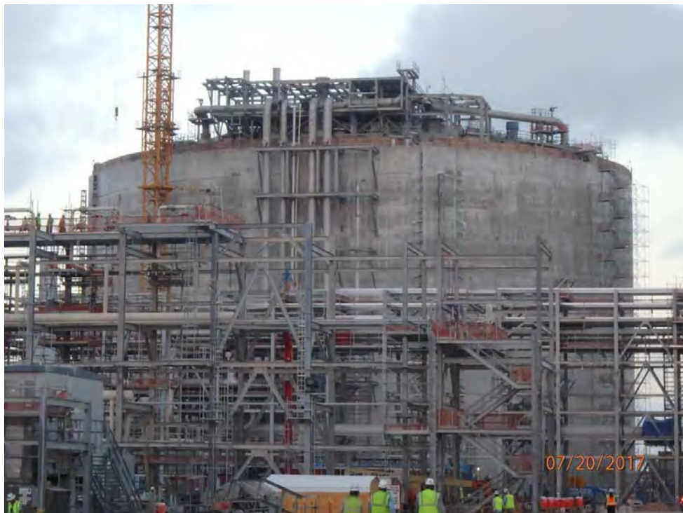
LNG Tank A – Pipe Installation
