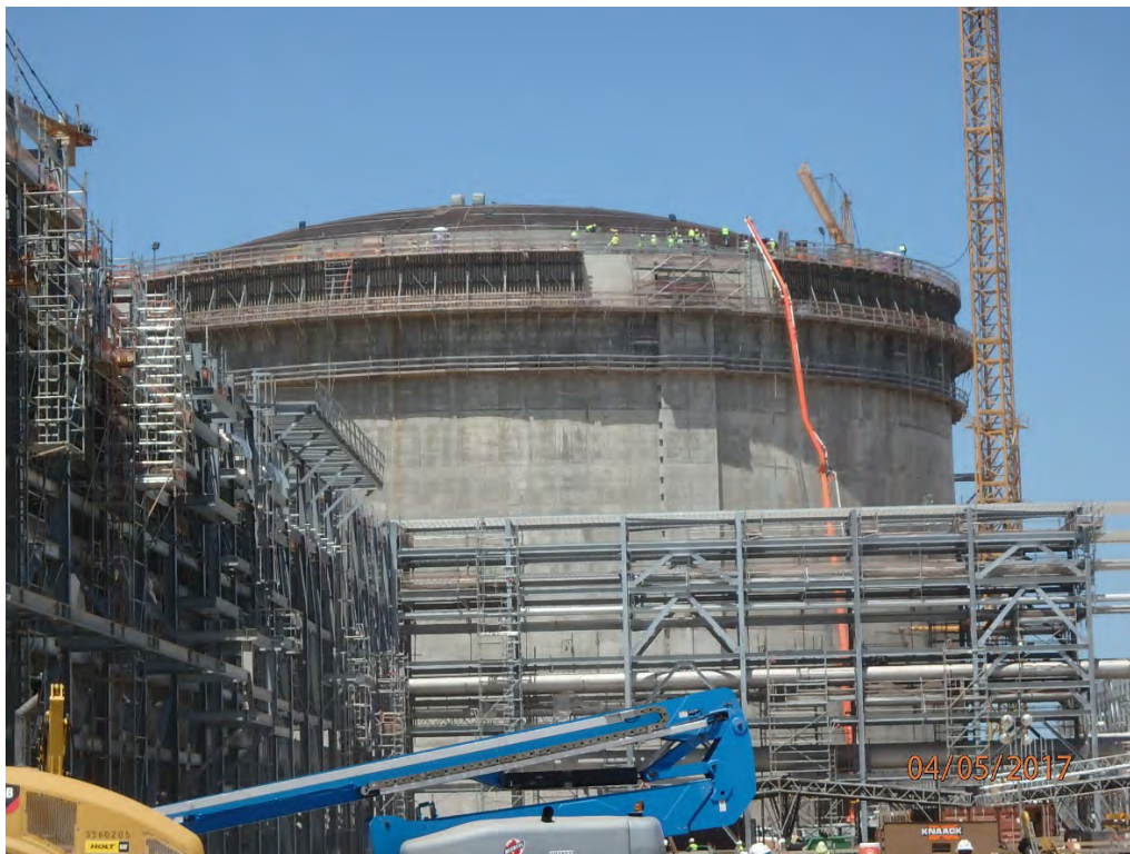
LNG Tank C – Roof Concrete Placement
