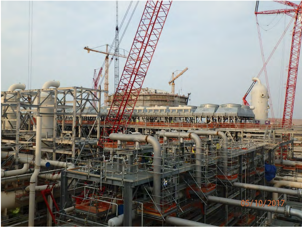
Train 1 – Cryo Fin Fan Setting
