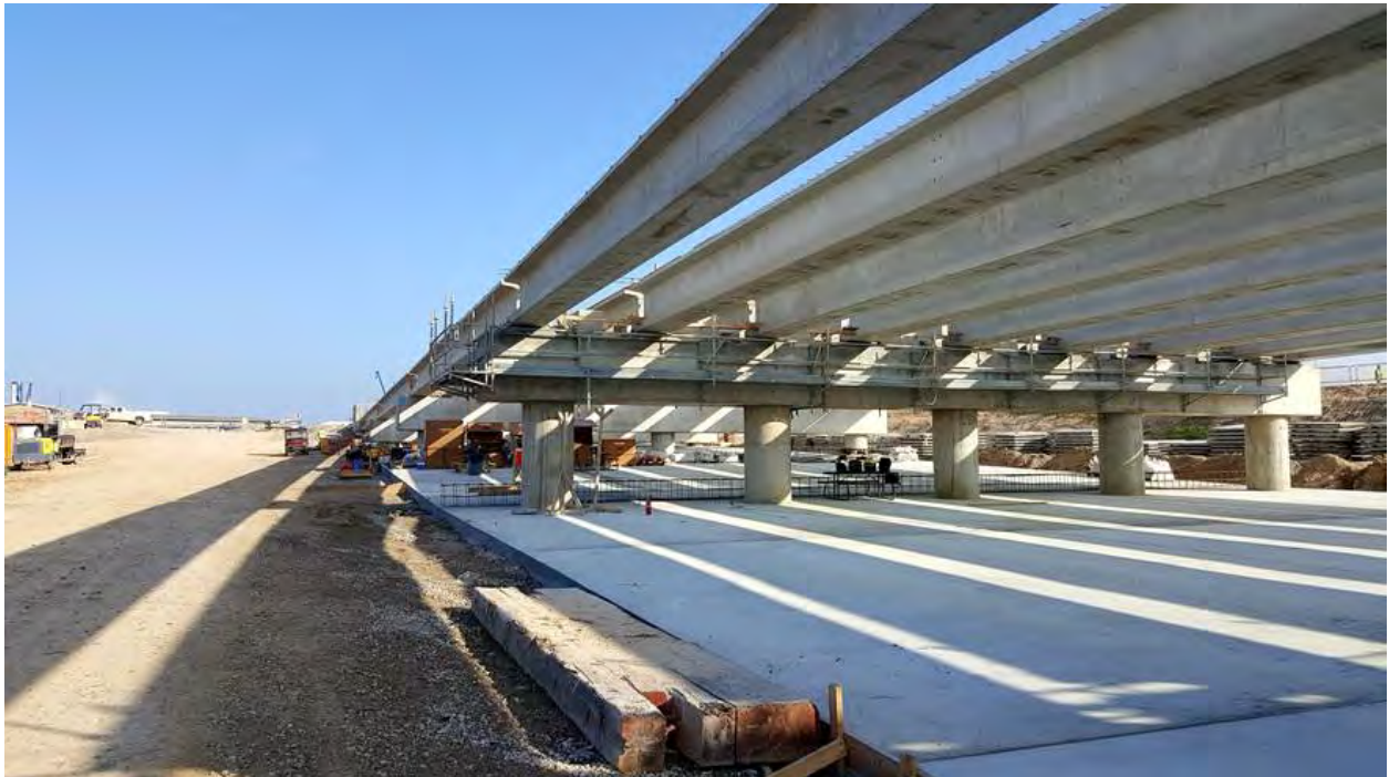
OSBL – Protection Slab Curb Concrete Pour
