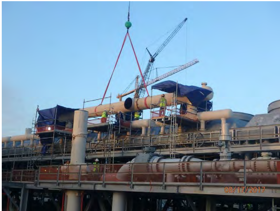
Train 1 – Fin Fan Header Installation
