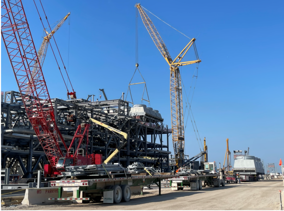
Photo 3: Train 7 Fin Fan Installation
