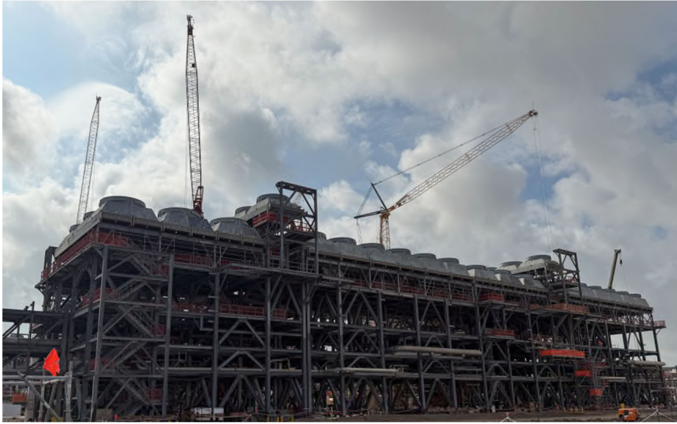
Photo 2: Train 7 Fin Fan Installation
