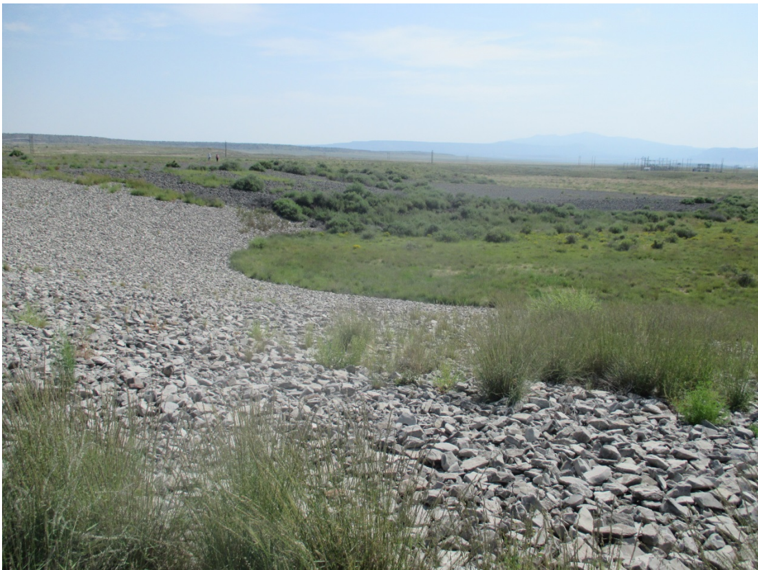
BLU 8/2015. PL-12. Asbestos disposal area.
