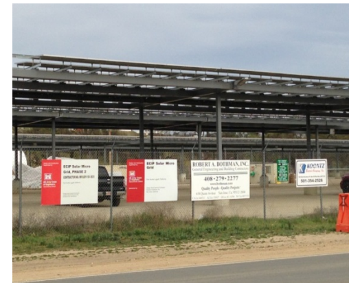
FHL 1 MW Carport PV
